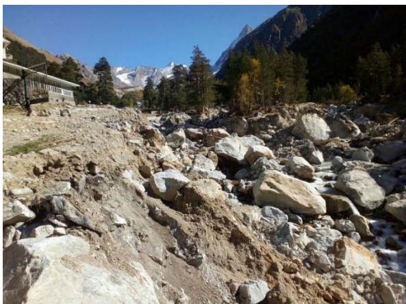
Рис. 12. Последствия прорыва озера и схода селевого потока в ущелье реки Адылсу. Фото Джапшуева Д.Р.
